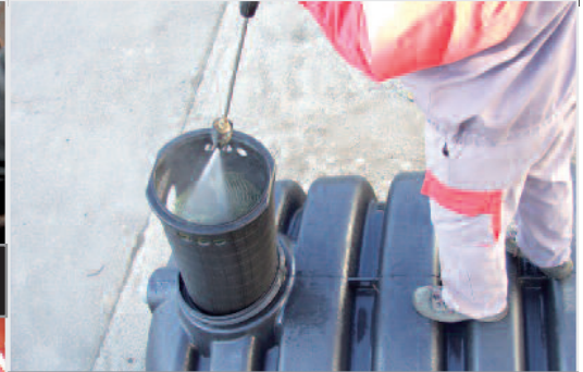
5 – Bloquear el prefiltro por el fondo sobre el manguito de salida.
