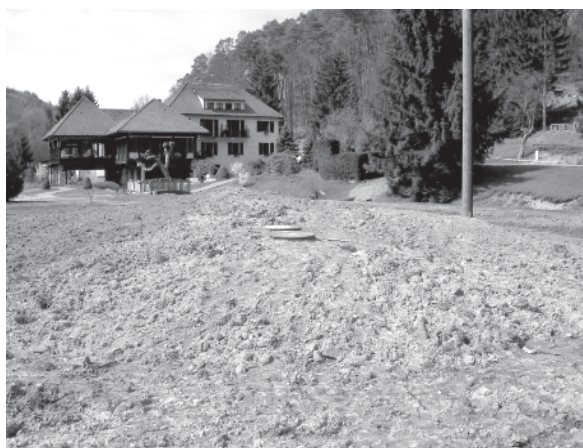
L'Arnsbourg à Baerenthal (F-57). Colocación semienterrada, terminación con tierra vegetal y plantación de césped
